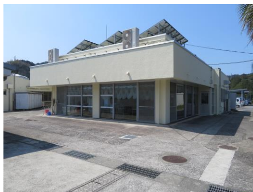
食堂 外壁塗装
