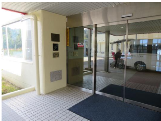
玄関 外壁塗装
