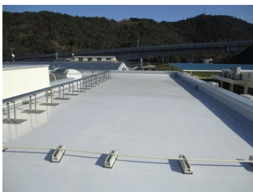
屋根防水 第1区居室上部
