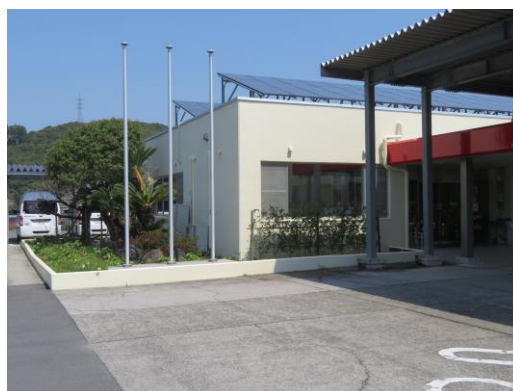
玄関 外壁塗装
