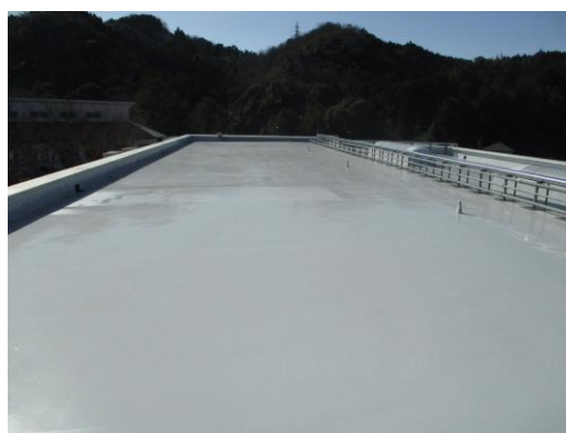
屋根防水 第3区居室上部
