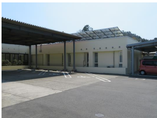
スタッフルーム 外壁塗装
