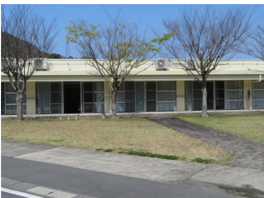
居室 外壁塗装
