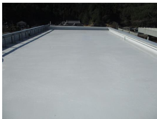
屋根防水 宿直室・更衣室上部
