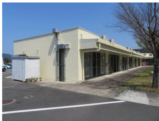
居室 外壁塗装
